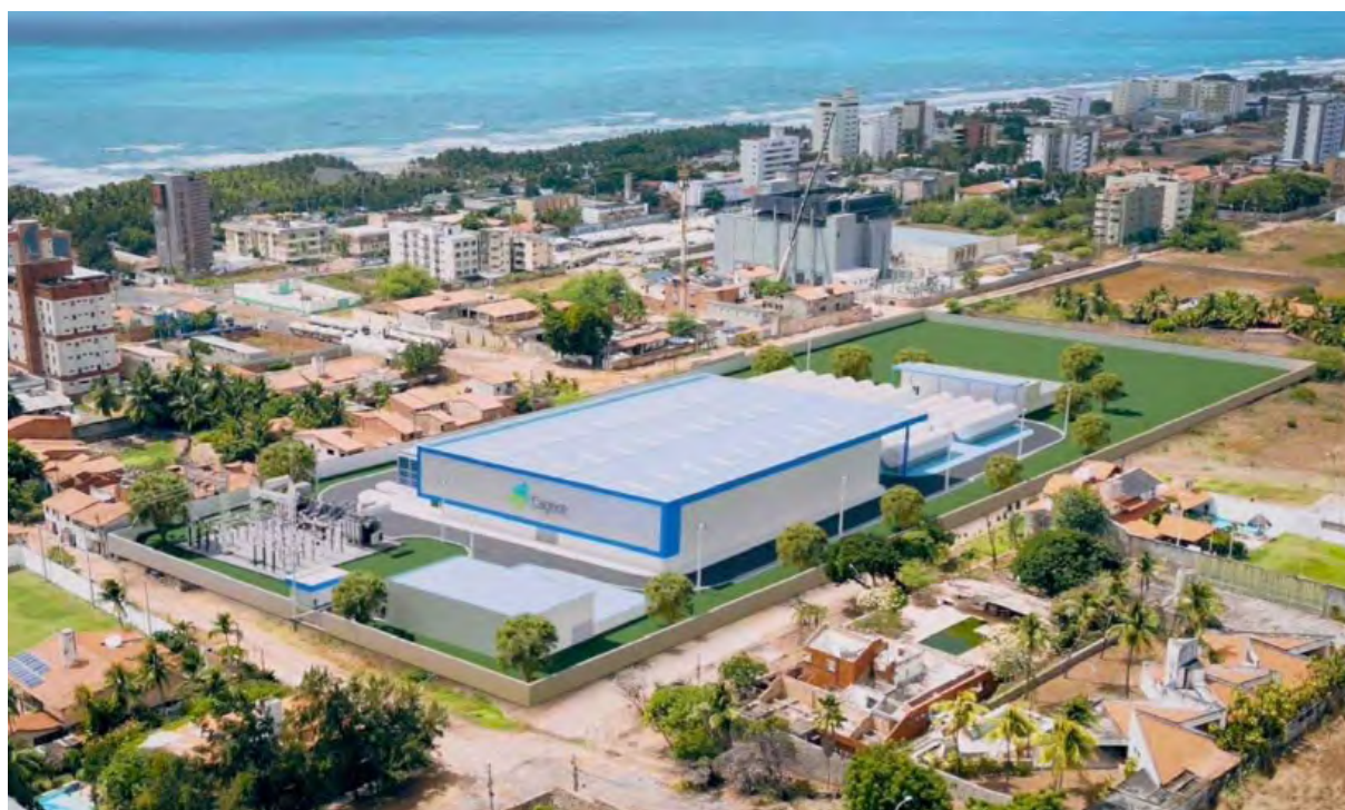
FIGURA 15 – Usina de Dessalinização de Fortaleza
