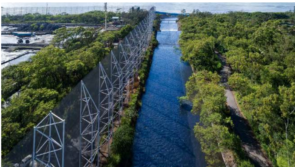
FIGURA 12 – Canal de retorno da água ao mar – ArcelorMittal Tubarão
