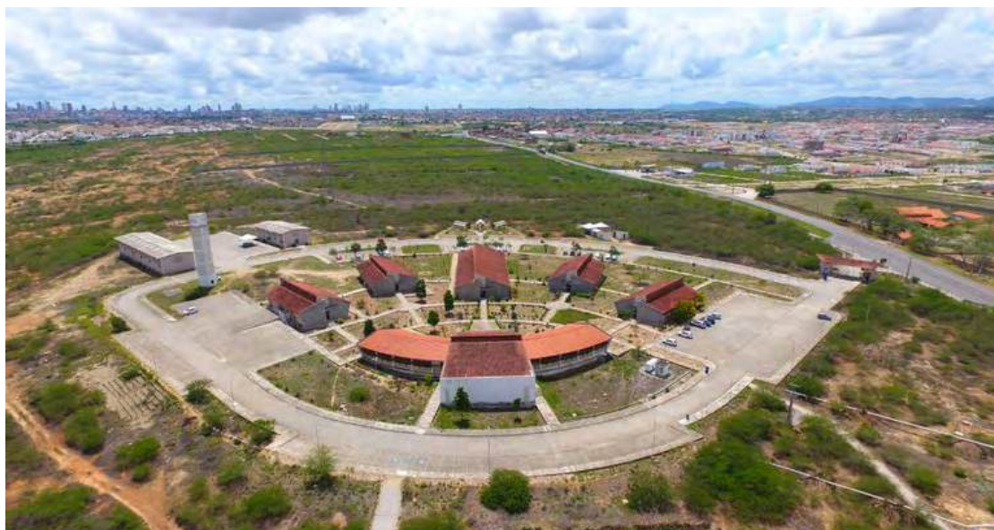
FIGURA 16 – Centro de Testes de Tecnologias de Dessalinização (CTTD) 28
