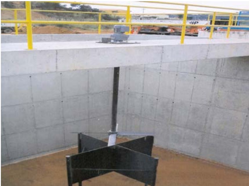
FIGURA 11.6 Floculador - fluxo axial
