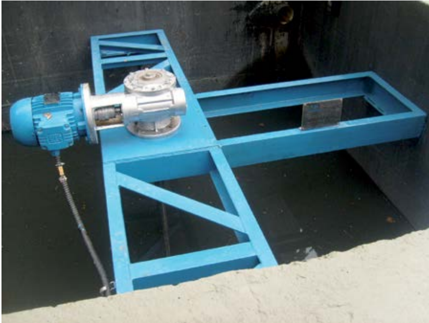
FIGURA 11.5 Floculador mecânico tipo axial
