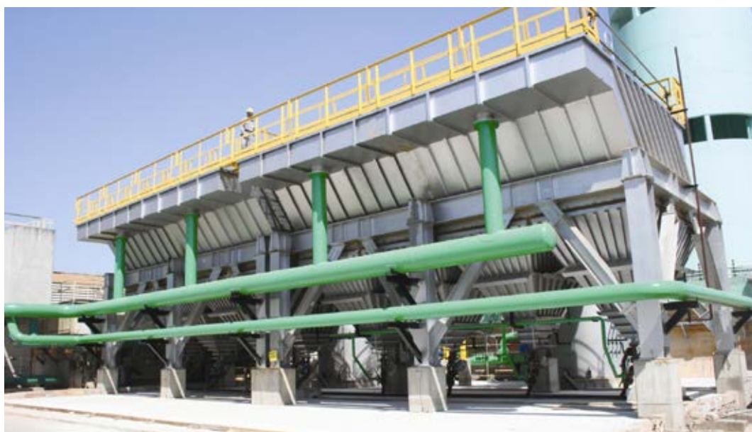
FIGURA 9.15 Decantadores lamelares
