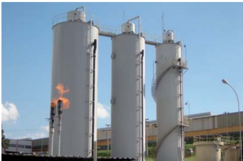
FIGURA 12.43 Reatores IC para tratamento de Efluentes
