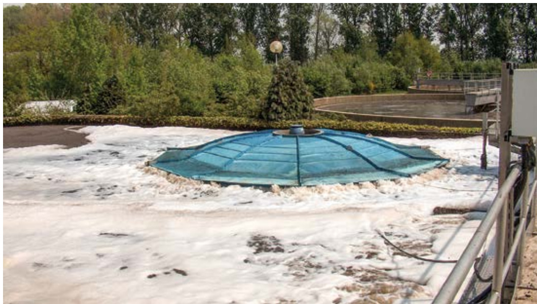
FIGURA 12.34 Aerador flutuante de alta rotação com cobertura
