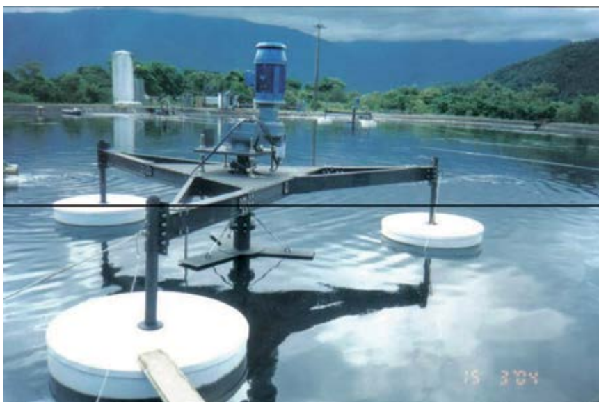
FIGURA 12.31 Aerador flutuante de baixa rotação
