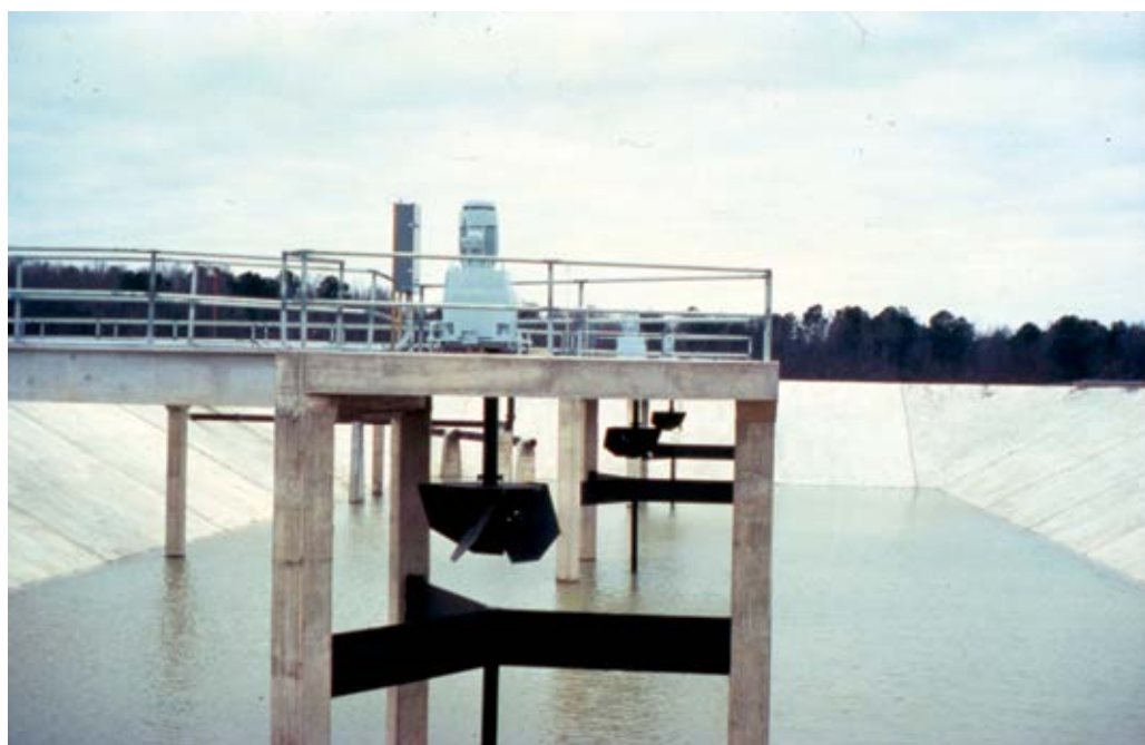
FIGURA 12.30 Aerador fixo de baixa rotação
