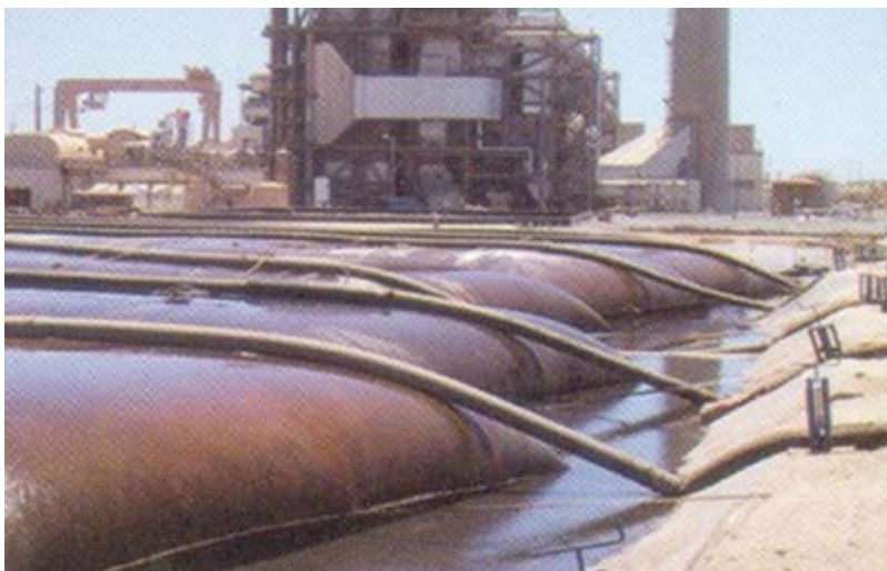
FIGURA 17.7 Desaguamento de lodos em tubos de geotextil
