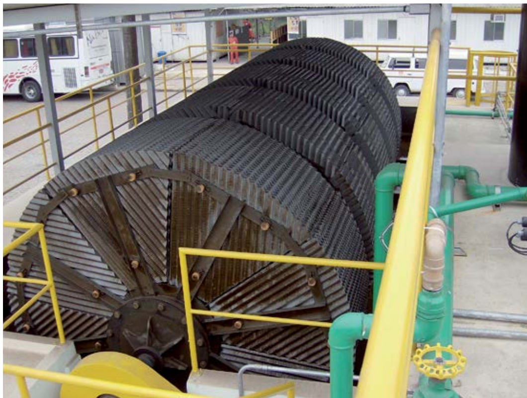
FIGURA 12.25 Disco biológico rotativo
