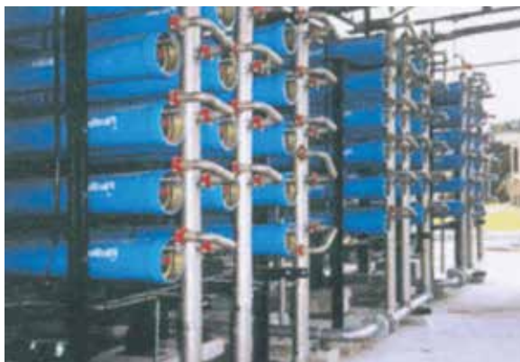
FIGURA 14.10 Sistema de Desmineralização por Osmose Reversa
