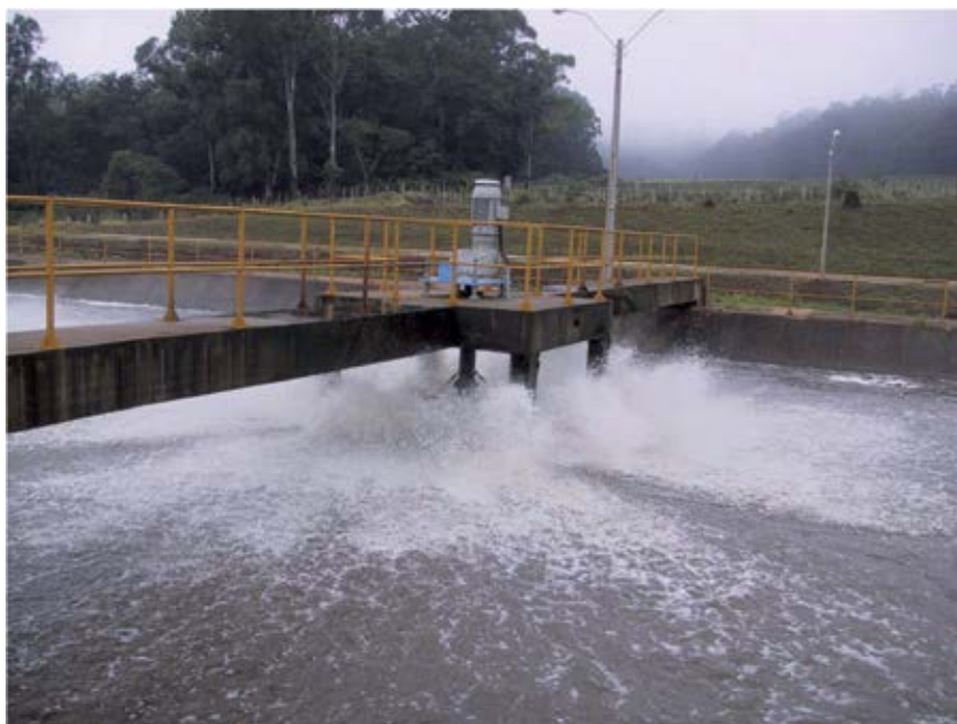
FIGURA 12.33 Aerador fixo de alta rotação (Aqua – Jet)
