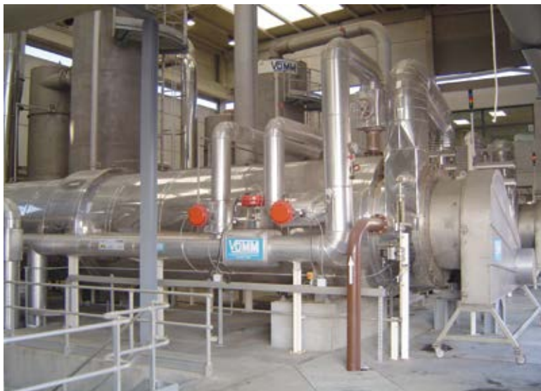
FIGURA 17.6 Secador térmico de lodos
