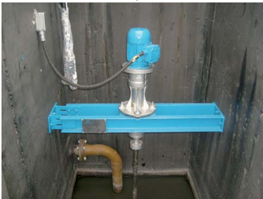
FIGURA 11.3 Misturador rápido vertical
