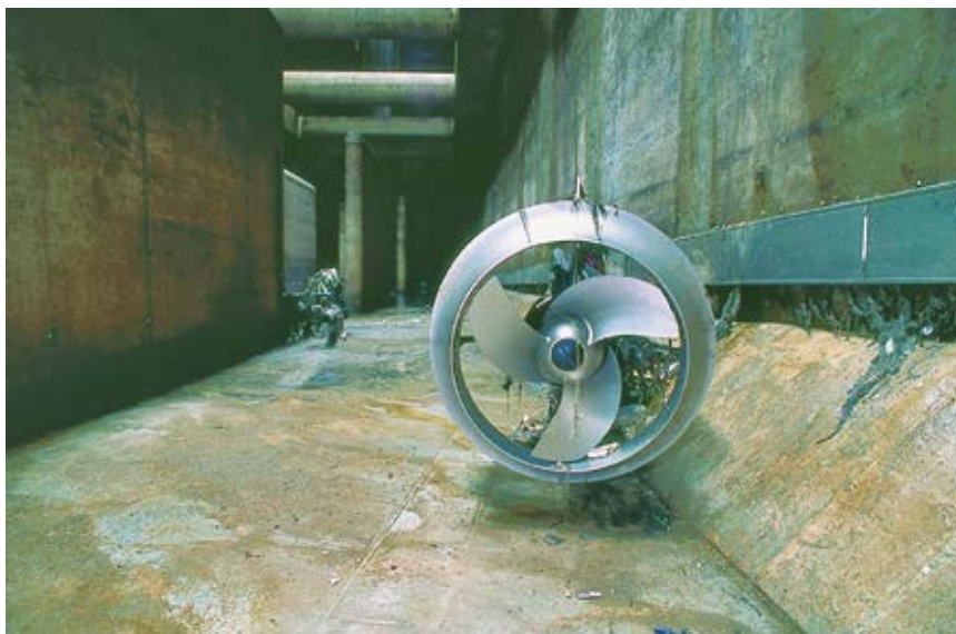
FIGURA 11.4 Misturador submersível
