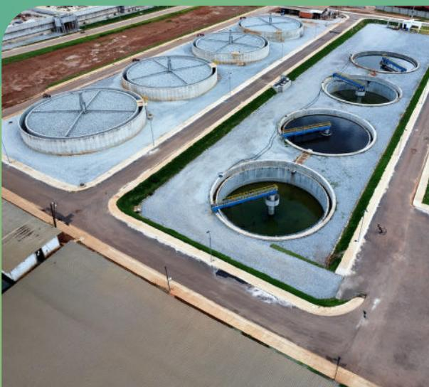
**Removedores de Lodo Tipo Tração Periférica e Distribuidores Rotativos Hidráulicos**
