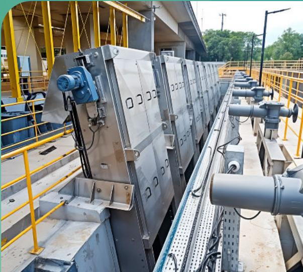
**28 Grades Mecanizadas de Múltiplos Rastelos fabricadas em aço inox 316**
