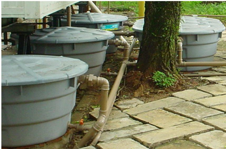
**Foto 8: Reservatórios onde as águas cinzas eram coletadas separadamente**
