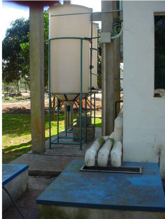
**Foto 15: Vista da chegada da tubulação coletora e do reservatório de auto-limpeza**
