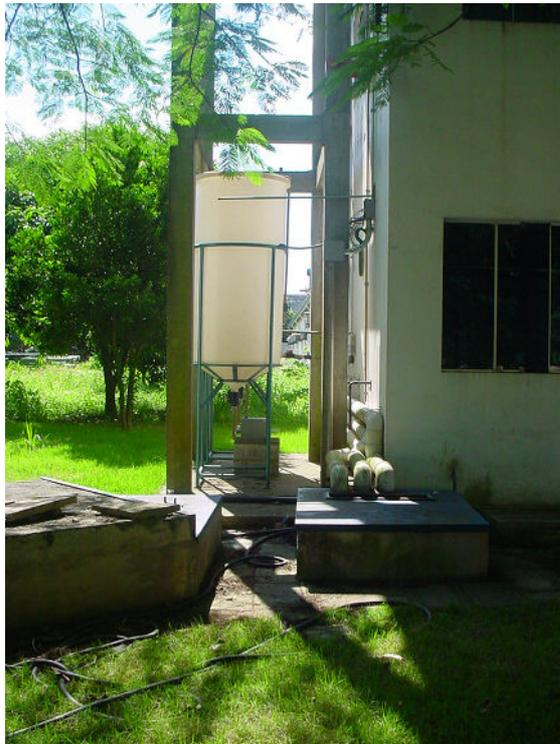
**Foto 14: Sistema experimental de coleta de águas pluviais: os reservatórios de auto-limpeza e de acumulação são encontrados em primeiro plano**
