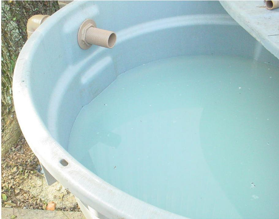
**Foto 16: Reservatório de acumulação contendo águas cinzas misturadas**
