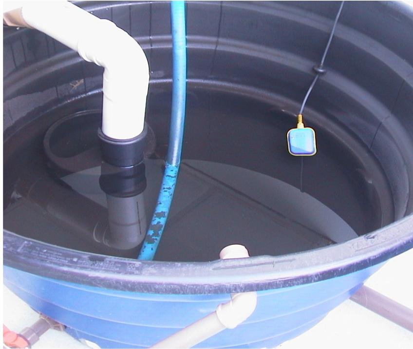
**Foto 1: Reservatório de acumulação de águas pluviais**
