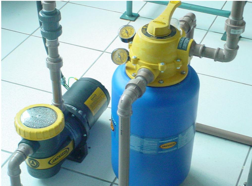
**Foto 2: Vista do filtro de areia e da bomba auto-escorvante utilizados para filtrar as águas pluviais**
