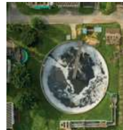
TRATAMIENTO DE AGUAS RESIDUALES PARA DISPOSICIÓN FINAL O REÚSO CIUDAD DE CAJAMARCA
