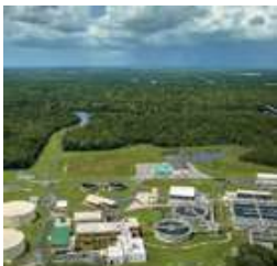
PLANTA DE TRATAMIENTO DE AGUAS RESIDUALES DE HUANCAYO
