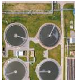
TRATAMIENTO DE AGUAS RESIDUALES PARA DISPOSICIÓN FINAL Y/O REÚSO PROVINCIA DE CHINCHA
