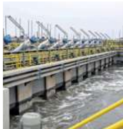
OBRAS DE CABECERA Y CONDUCCIÓN PARA EL ABASTECIMIENTO DE AGUA POTABLE PARA LIMA (1ra fase)
