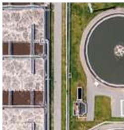
TRATAMIENTO DE AGUAS RESIDUALES PARA DISPOSICIÓN FINAL O REÚSO CAÑETE
