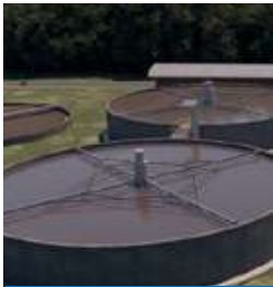
PLANTA DE TRATAMIENTO DE AGUAS RESIDUALES PUERTO MALDONADO
