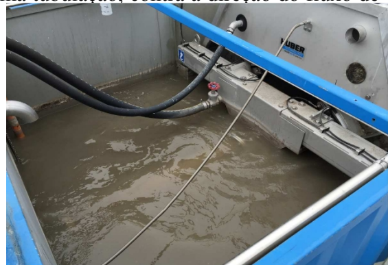
Fig. 8: Fluxo para a peneira de tambor da HUBER LIQUID com o nível máximo de água a montante [8]
