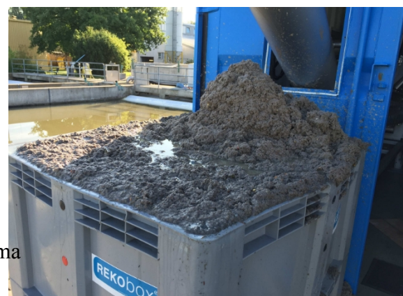
Fig. 9: Peneiras finas pré-desaguadas da HUBER Screenings Wash Press WAP® líquido para digestão [8]
