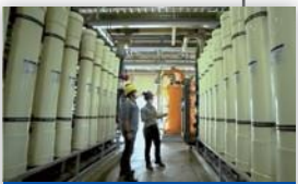
Dessalinização Água do Mar: 28,000m³/d
