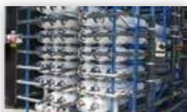
Reuso de Efluentes: 70,900m 3 /d
