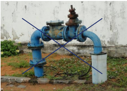
Poço fora de norma.
