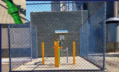
Poço conforme Norma ABNT.
