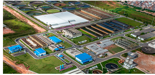
Figura 5: ECONSSA – Atacama/Chile. Dessalinização de água do mar (1,2 m 3 /s) consumo 2,8 kWh/m 3 .
