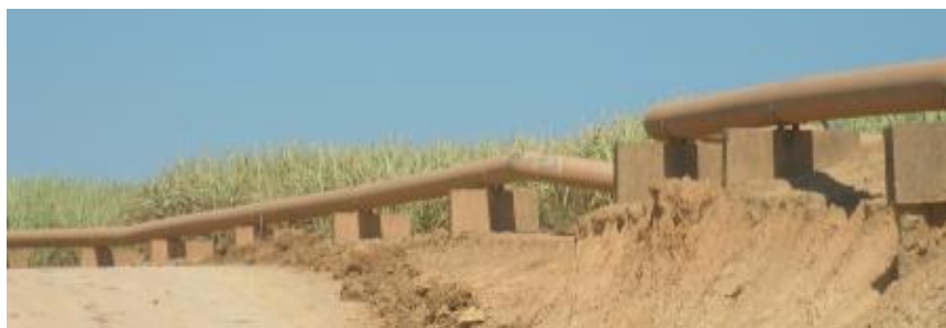
Figura 3. Tubulações para transporte de vinhaça. Foto: Daniel Nassif.
