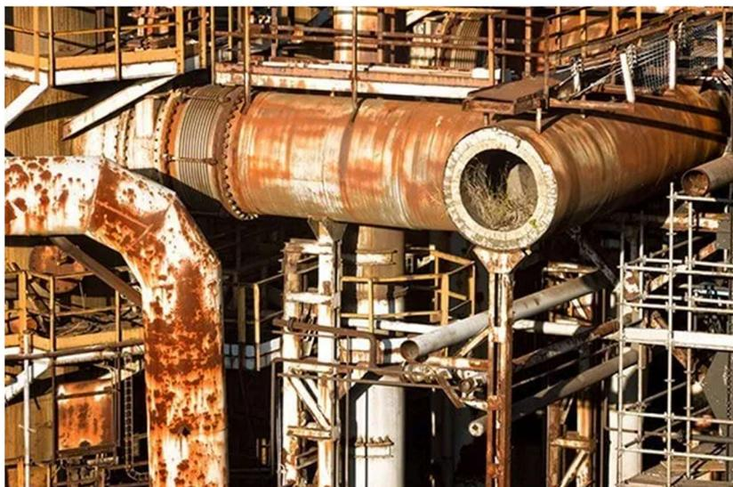
*Figura 4-1: Corrosão (ferrugem) de tubulações e juntas [6]*
