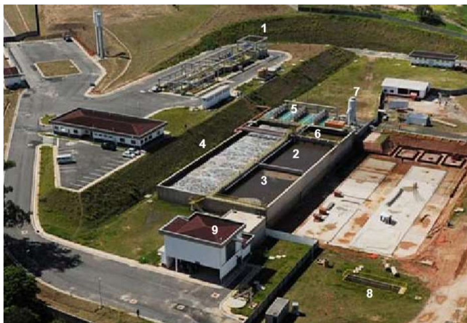
Figura 06. Estação Produtora de Água de Reuso
