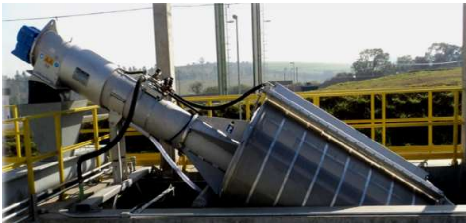
Figura 07. Peneira Rotativa com abertura de 2mm
