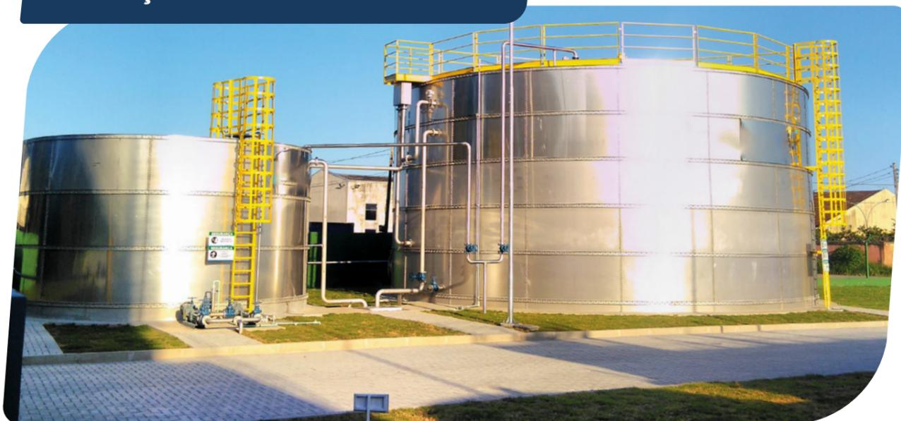
A Fast oferece sistemas de armazenamento desenvolvidos em aço inoxidável sempre atendendo às necessidades dos clientes e seus respectivos projetos. Os reservatórios Fast podem ser fornecidos como um tanque aberto ou com coberturas. Com design modular, os tanques em aço inox podem facilmente ser desmontados ou realocados. Devido à utilização de materiais da mais alta qualidade, são extremamente duráveis e têm uma vida útil maior.
