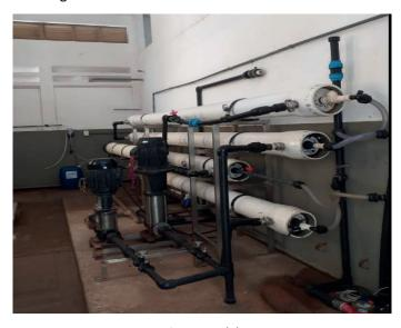
Figura 6 - Sistema de osmose inversa do HU-UFMA
