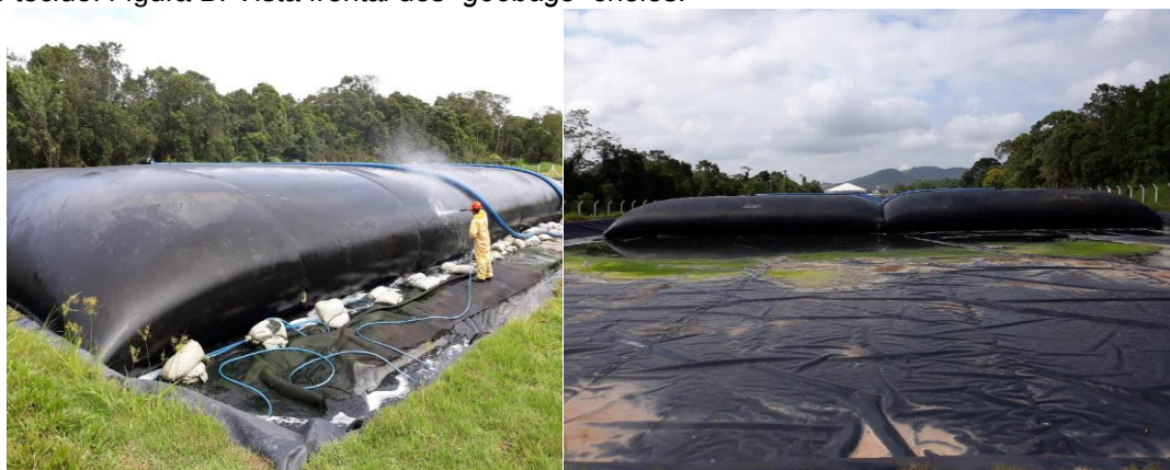
Figura 2 - Figura A: Hidrojateamento com “geobag” cheio para impedir a colmatação dos poros do tecido. Figura B: Vista frontal dos “geobags” cheios.
