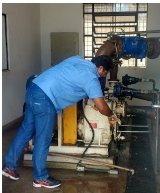
*Figura 57: Engenheiro Fabrício realizando limpeza da bomba durante a visita*
