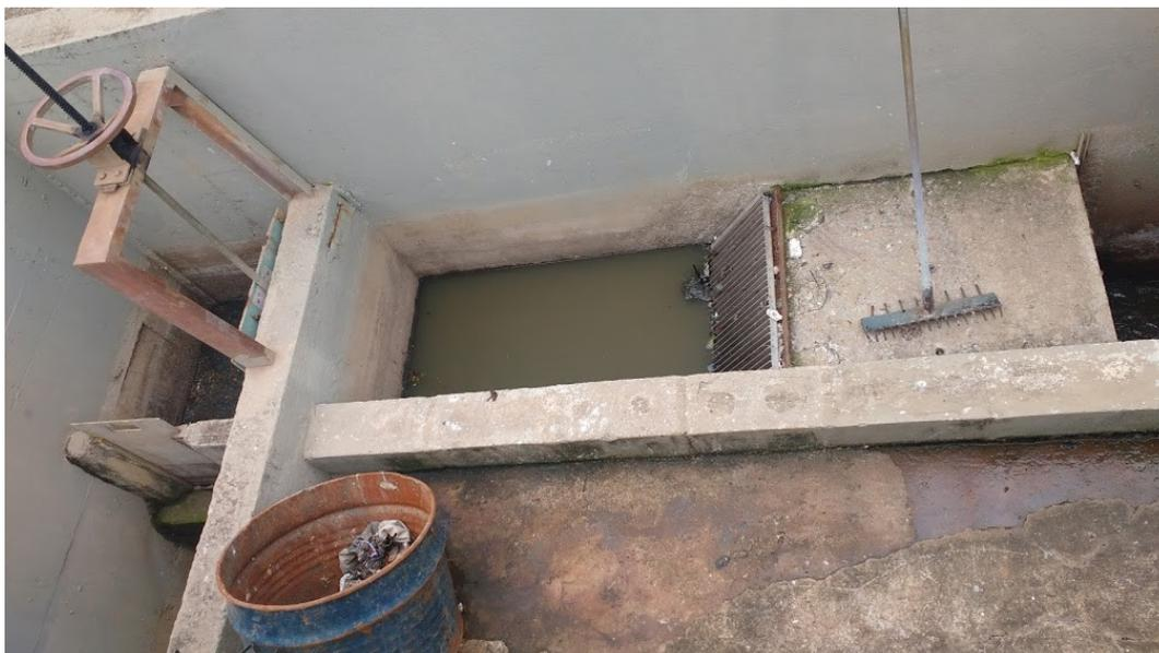
*Figura 50: Sistema de pré-tratamento da elevatória de Carabina*
