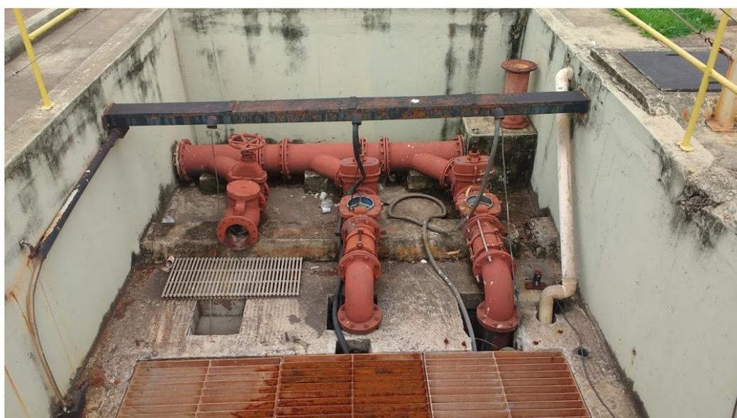
*Figura 51: Tubulação de recalque da elevatória de Carabina*
