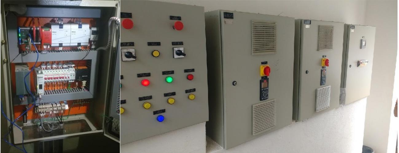
*Figura 4: Quadros de comando de elevatórias de esgoto*
