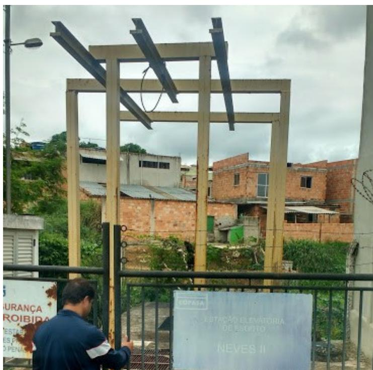
*Figura 37: Estrutura metálica (em amarelo) facilita a manutenção na elevatória Neves II*
