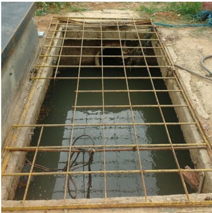
*Figura 41: Esgoto extravasando pela tubulação*
