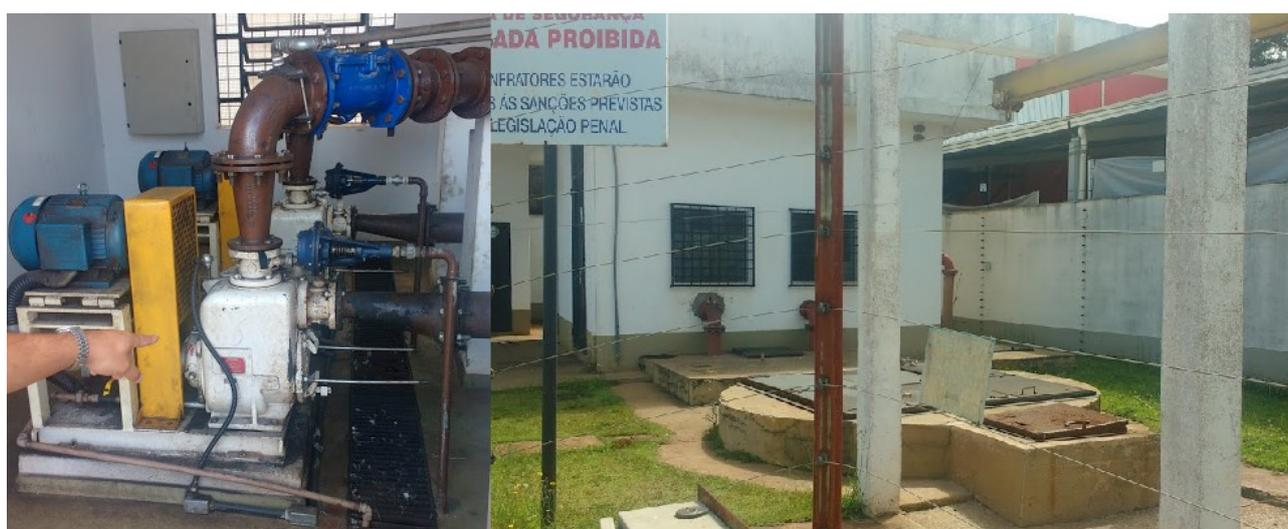
*Figura 54: Bombas autoescorvantes e estrutura da elevatória de Canadá*
