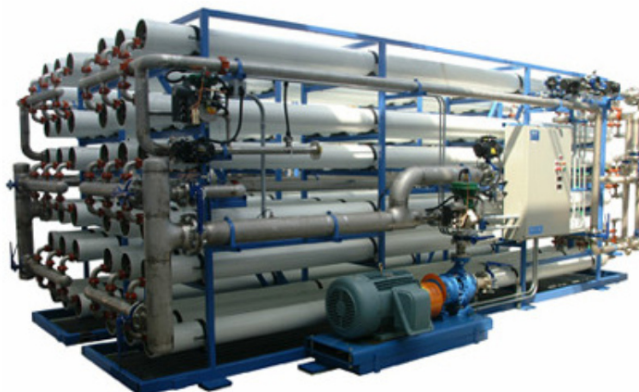
Figura 2.5 – Planta industrial de osmose reversa
