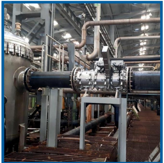
O sistema de SWRO (dessalinização da água de mar) emprega um processo de tratamento de múltiplas etapas que incluem um clarificador, filtro de disco, membrana de ultrafiltração (UF), microfiltros, skids OR e tratamento posterior. O sistema OR consta de 12 skids, cada um de 750 m<sup>3</sup>/hora de alimentação da água de mar.
