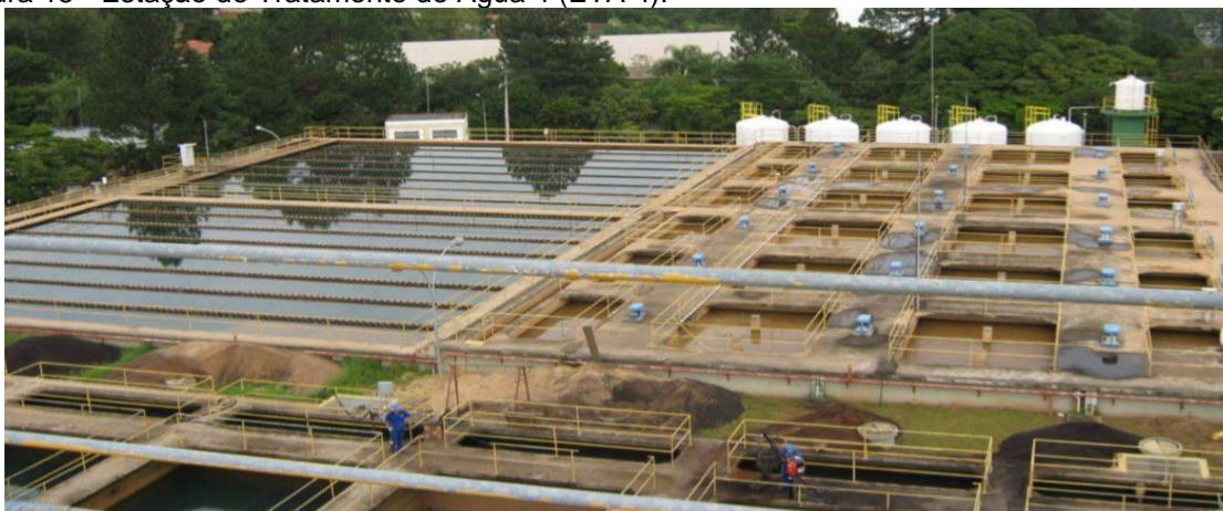
Figura 15 - Estação de Tratamento de Água 4 (ETA 4).
