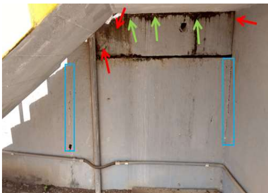
Figura 12: Fissuras (—), bolor (—) e manchas por oxidação (—) na laje inferior dos valos de oxidação.
