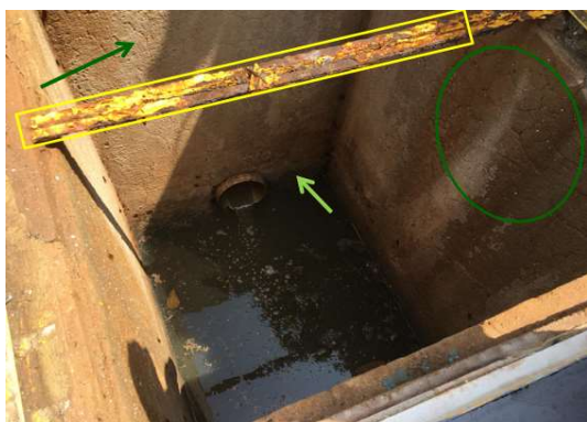
Figura 20: Presença de bolor (==), corrosão (==) e Reação Álcalis-Agregado (==) na caixa de entrada do poço úmido da ETE do município de Recife.
