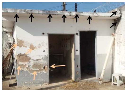
Figura 21: Presença de manchas pela ação de agentes externos (==) e descolamento com pulverulência (==) na casa de apoio de EE.
