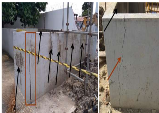
Figura 16: Trincas (—) e manchas pela ação de agentes externos (—) na parede da caixa do barrilete de EE.
