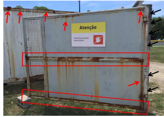
Figura 11: Manchas pela ação de agentes externos (—) e oxidação (—) em portão metálico.
