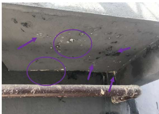
Figura 14: Eflorescência (—) encontrada na parte inferior da laje da caixa de areia.
