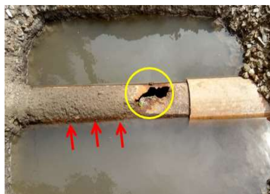
Figura 17: Corrosão (—) e manchas por oxidação (—) na tubulação de chegada do efluente.
