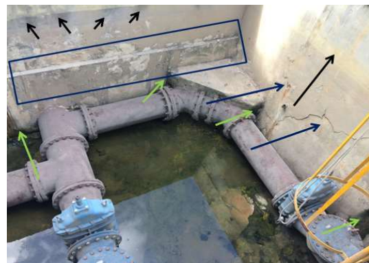
Figura 13: Descolamento por empolamento (—), manchas pela ação de agentes externos (—) e bolor (—) na caixa do barrilete de EE.
