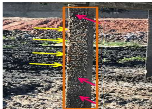
Figura 19: Lixiviação (—), ataque de sulfatos (—) e corrosão (—) na laje inferior da caixa de reunião da ETE.
