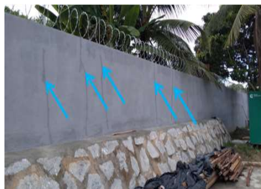
Figura 7: Fissuras (==) no muro externo de EE.
