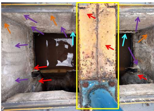
Figura 18: Abrasão (—), corrosão (—), oxidação (—), eflorescência (—) e ação do ataque de sulfatos (—) na caixa de saída de ETE.
