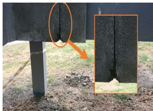
Figura 5: Ataque de sulfatos (→) na caixa de reunião de ETE.
