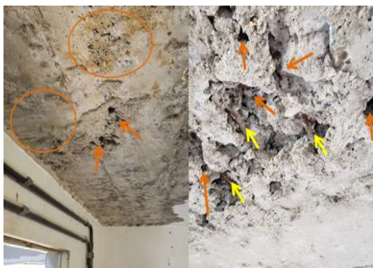
Figura 6: Corrosão (==) e ação pelo ataque dos sulfatos (==) encontrados na laje superior de estrutura da ETE.
