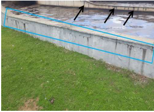
Figura 10: Fissuras (—) e manchas pela ação de agentes externos (—) nas paredes internas e externas dos valos de oxidação.
