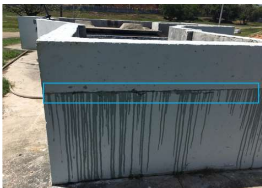
Figura 8: Fissuras (==) na caixa de saída do afluente.
