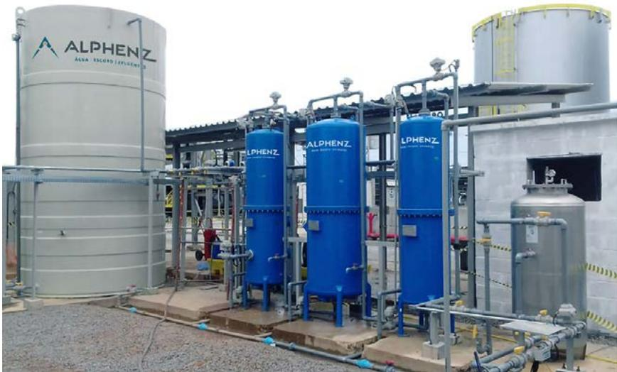
**Figura 4.5:** Sistema de desmineralização por troca iônica.
