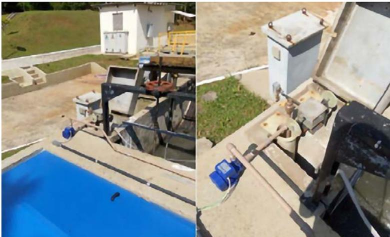
**Figura 6.16:** Imagens da bomba instalada na captação de esgoto.
