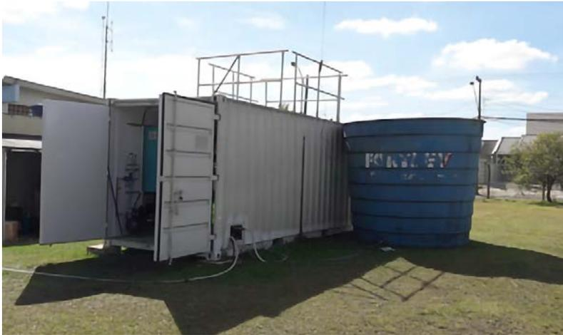
**Figura 6.15:** Imagem do contêiner posicionado na área de estudo e do tanque-pulmão de 15 m<sup>3</sup>.
