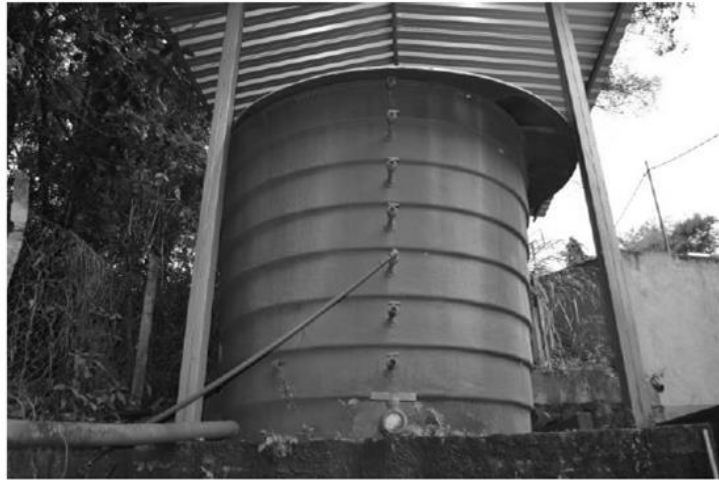
Figura 3. Tanque de decantação do lodo gerado na ETA da UFLA.
