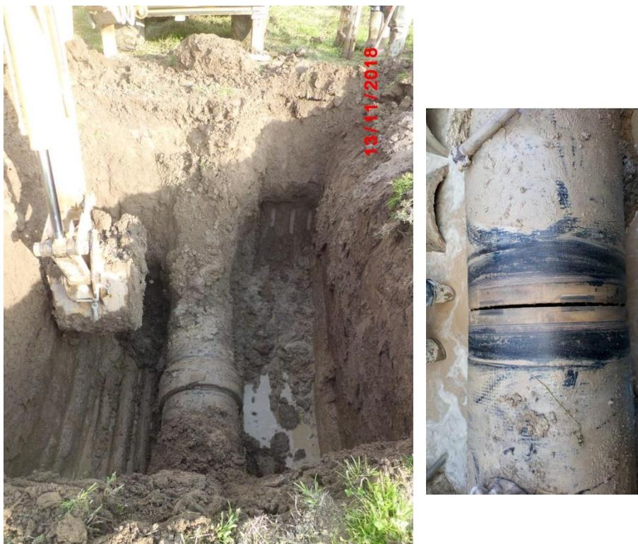
**Fotografia 1 – Trecho com vazamento a ser reparado**
