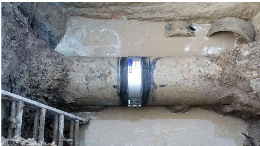
**Fotografia 2 – Trecho com vazamento reparado com a abraçadeira universal**
