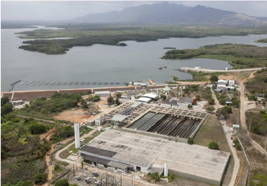
Figura 03: Estação de Tratamento de Água do Gavião. Fonte: Governo do Estado Ceará, 2016.
