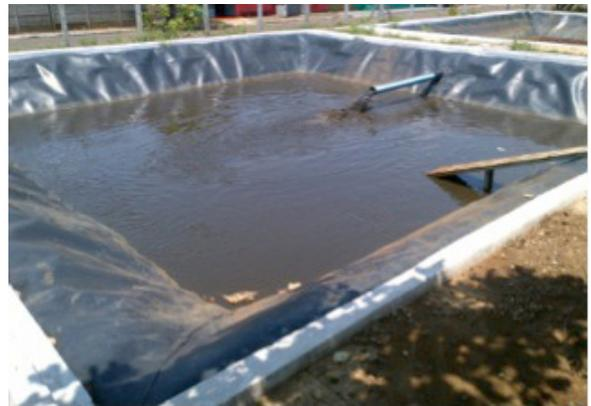
**Figura 10** - Disposição do lodo no leito de drenagem
