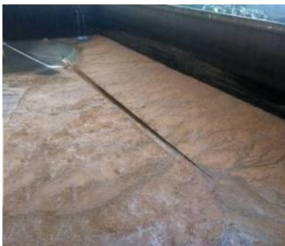
Fotografia 1 – Limpeza do decantador no dia da coleta da amostra
