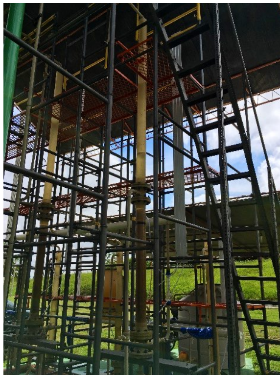
Figura 3.8 - Vista do Filtro rápido descendente de areia.
