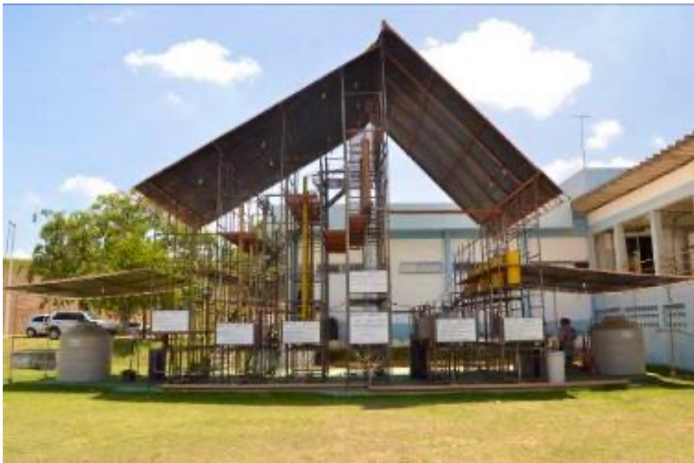
Figura 3.4 - Vista Geral da IPDF em Extremoz/RN.
