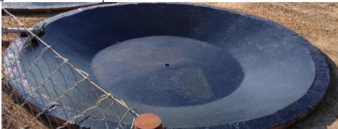
Figura 4. Reator de desinfecção solar de concreto
