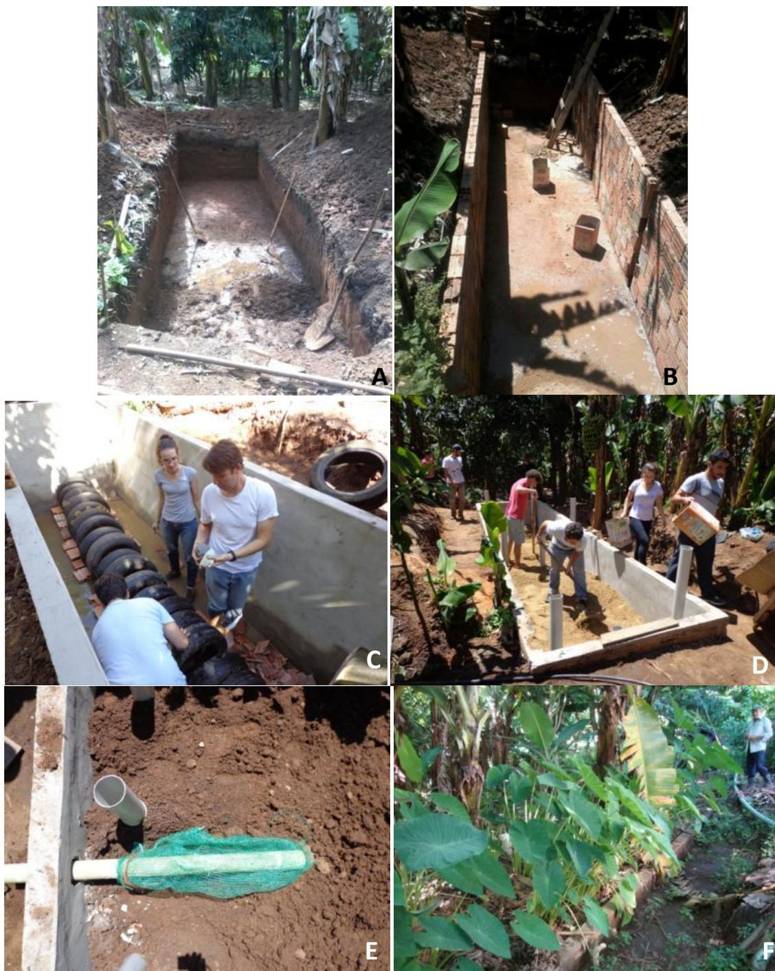
**Figura 6.6.** Etapas da construção da Bacia de evapotranspiração implantada em Pedra Branca, Campinas/SP. **A)** Solo escavado manualmente. **B)** Construção da caixa em alvenaria. **C)** Formação da câmara de pneus. **D)** Preenchimento da 3ª camada (areia grossa). **E)** Instalação do dreno na camada de terra. **F)** Sistema em operação, com taiobas e bananeiras produzindo e solo coberto com palhada seca.
