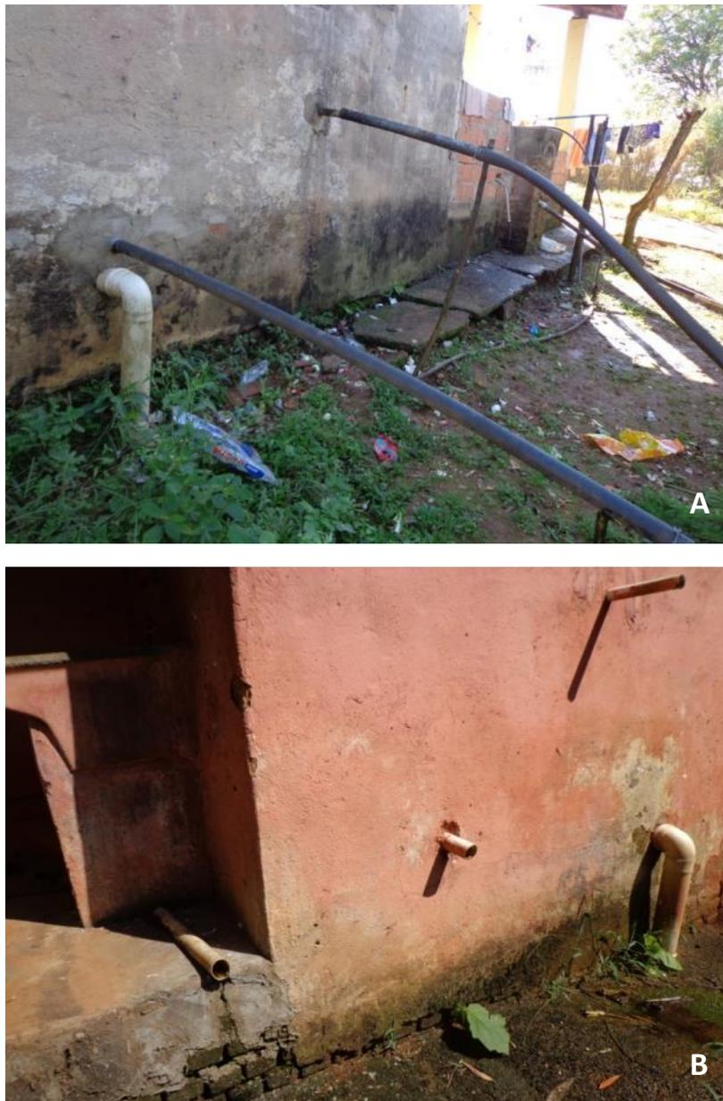
**Figura 4.4.** Imagens da segregação do esgoto em domicílios rurais de Pedra Branca. **A)** Águas cinzas (tubo flexível preto) e águas de vaso sanitário (tubulação de PVC branca). **B)** Águas cinzas do tanque, chuveiro e pia do banheiro (tubos de PVC branco abertos e mais finos) e águas de vaso sanitário (tubulação PVC 100 mm fechada).
