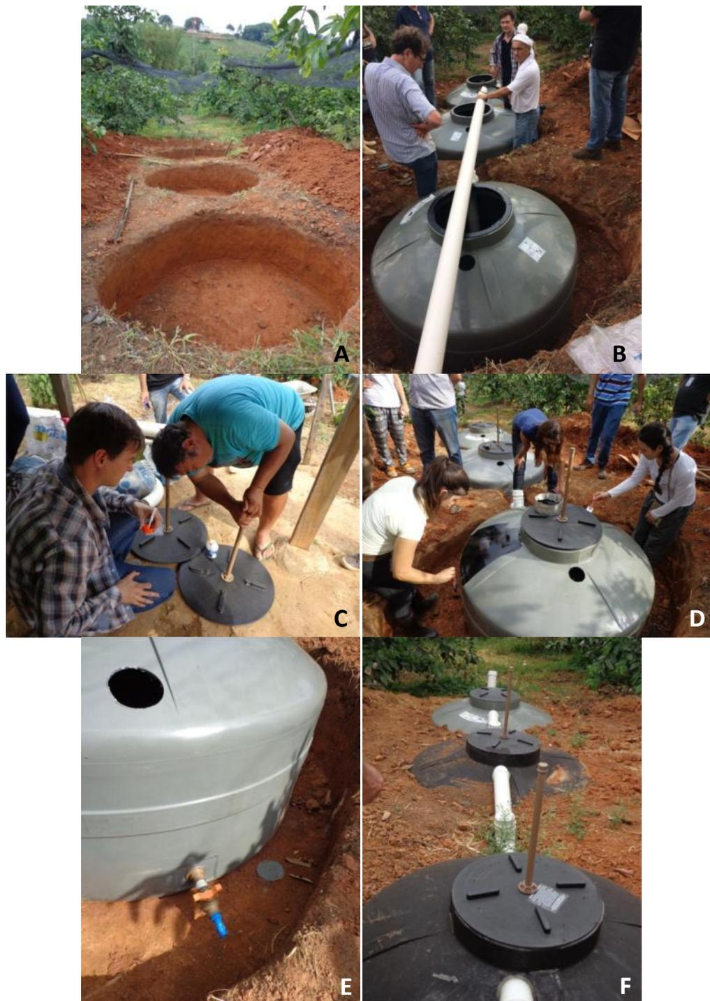
**Figura 6.2.** Imagens da construção da FSB implantada em Pedra Branca. **A)** Solo escavado e compactado manualmente. **B)** Instalação das caixas d'água e tubulação. **C)** Fabricação das válvulas de alívio de gases. **D)** Pintura das tampas. **E)** Detalhe do registro para remoção do efluente tratado. **F)** Vista geral do sistema pronto e em funcionamento.
