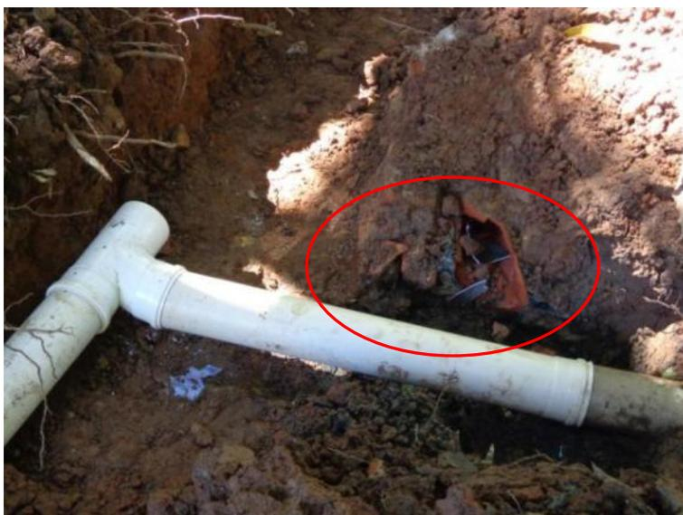
**Figura 8.12.** Nova tubulação de PVC instalada para alimentar o sistema de tratamento
