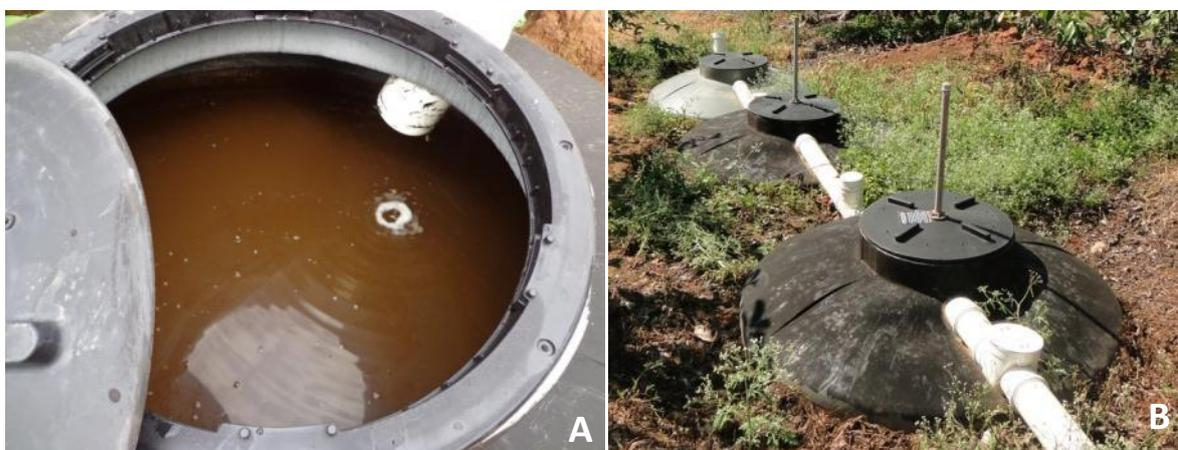
**Figura 6.5. A)** Detalhe da tampa rosqueável na caixa de polietileno de 1.000L. **B)** Sistema implantado em Pedra Branca, mostrando que o corpo das caixas fica parcialmente enterrado no solo.
