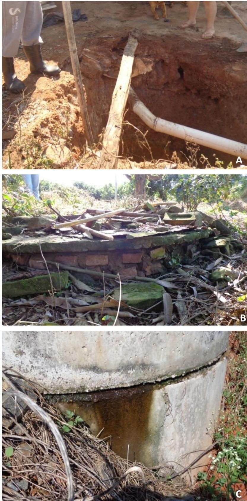
**Figura 4.11.** Formas de construção das fossas rudimentares de Pedra Branca. **A)** Sem revestimento (apenas escavação no solo). **B)** Tijolamento. **C)** Anel de concreto pré-moldado (na foto é aparente um vazamento na estrutura).
