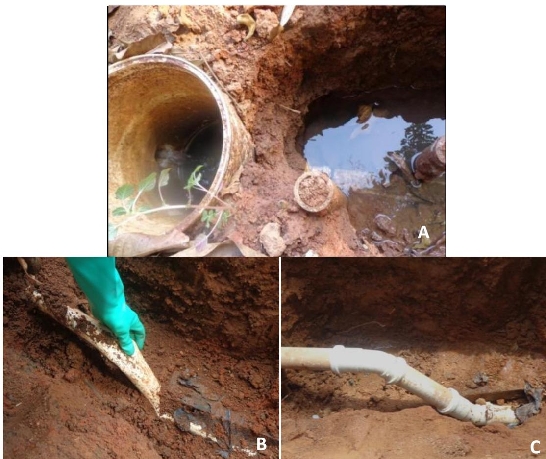
**Figura 8.5.** A) Vazamento do efluente na entrada da vala de bambu. B) Tubulação de saída da caixa sifonada danificada. C) Mesma tubulação reparada.
