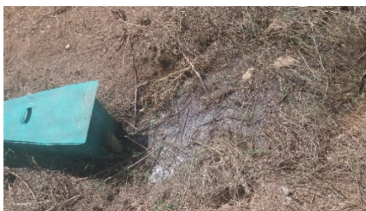
Figura 7: Vazamento no tratamento preliminar da ETE-2.
