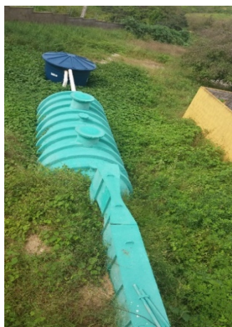
Figura 5: ETE-1 com excesso de vegetação no entorno.
