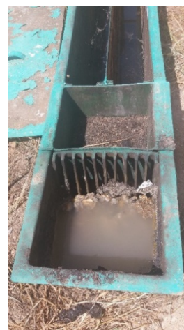
Figura 6: Tratamento preliminar da ETE-2 com obstrução e excesso de gordura e sólidos
