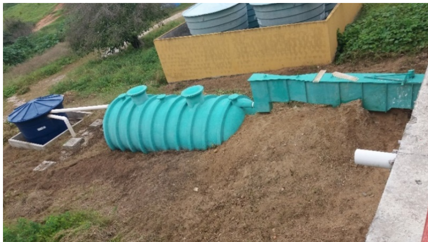
Figura 2: ETE-1 que trata os esgotos produzidos no bloco de aulas e auditório.
