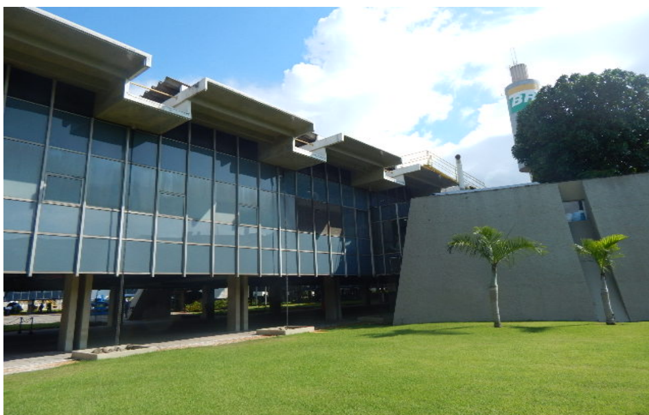
Figura 5: Edificação de captação da água pluvial Fonte: Próprio Autor, 2018
