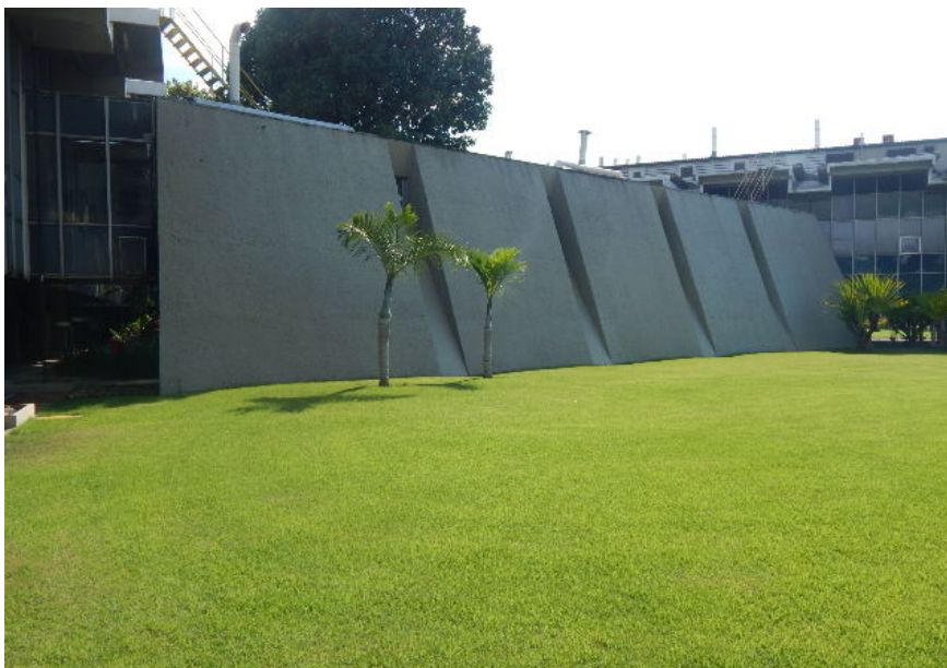
Figura 7: Edificação para armazenamento do reservatório Fonte: Próprio Autor, 2018
