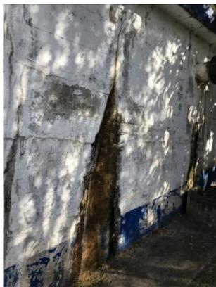
c) Rachadura na parede frontal
