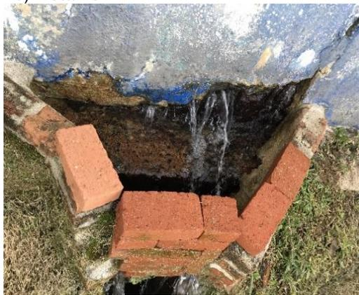
**Figura 10** – Fissuras e patologias no reservatório em concreto armado RAP001 do Simae Joaçaba
