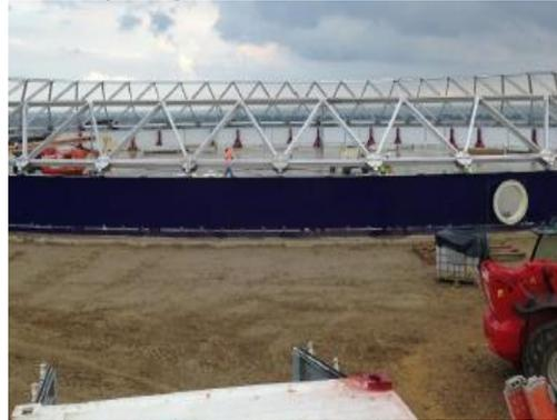
c) Instalação do esqueleto da cúpula geodésica de alumínio
