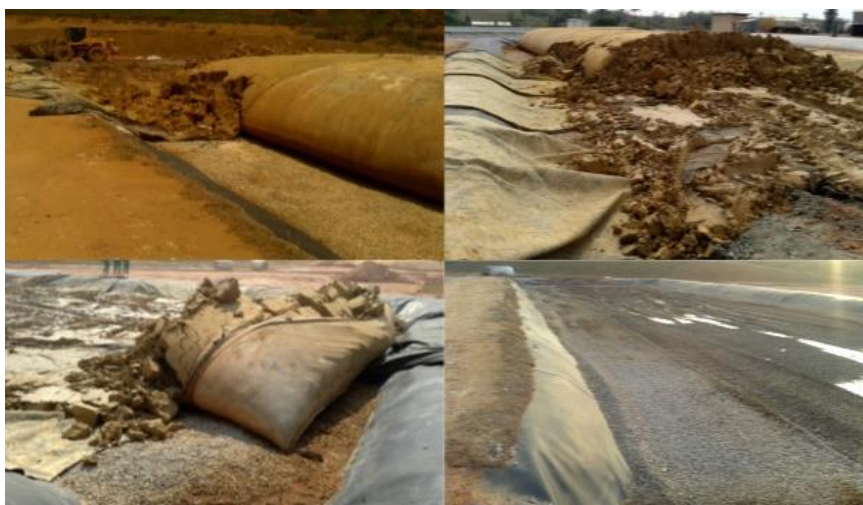
Figura 1: Lodo de chorume coletado em geobag, in loco .
