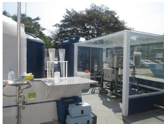
Figura 2. Sistema de produção de água de reuso na ETE Deodoro. Fonte: Obraczka et al. (2017).
