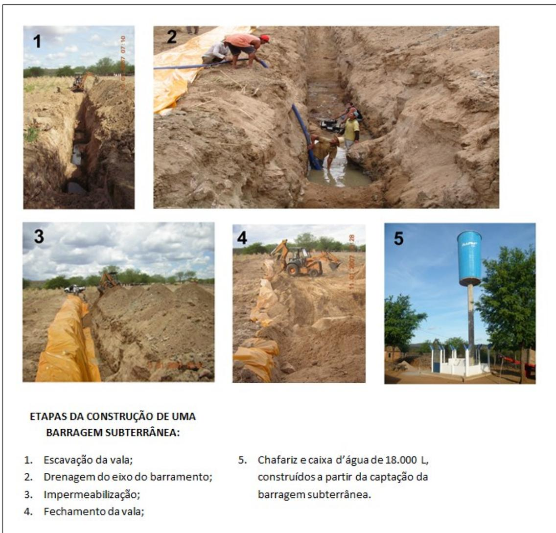
**Figura 3:** Etapas de construção de uma barragem subterrânea
