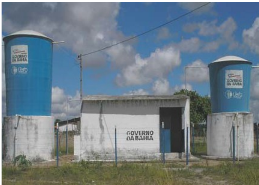
Figura 11 – Reservatórios de Cachoeirinha Fonte: CERB (2018)
