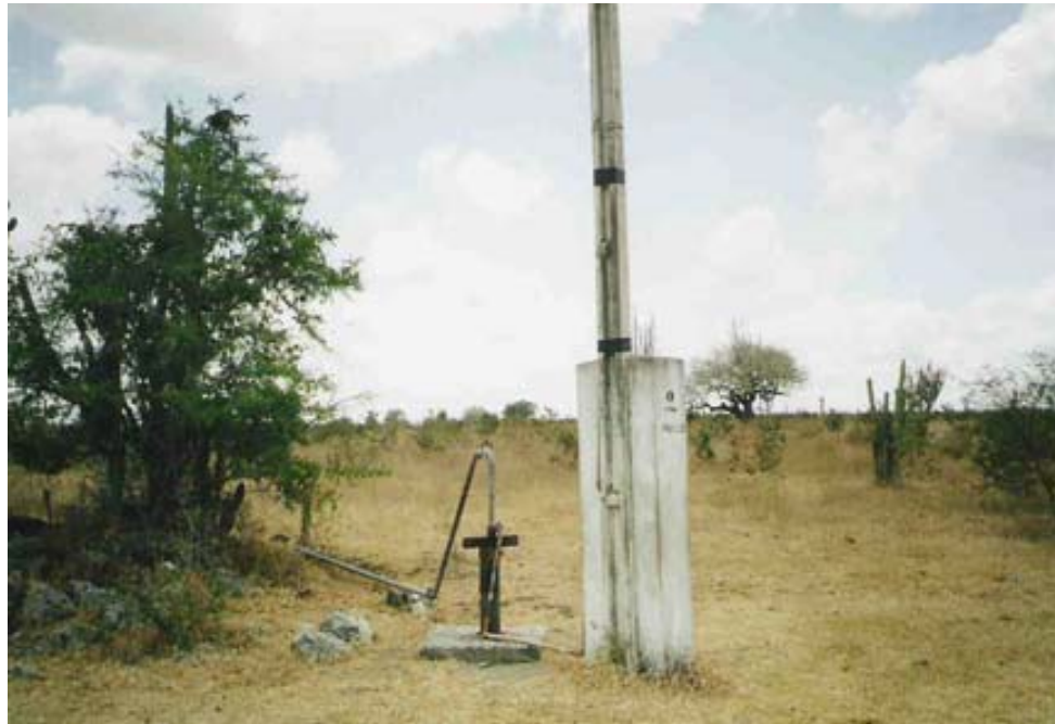
Figura 7 – Poço tubular de Cachoeirinha Fonte: CERB (2018)
