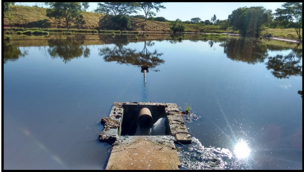
Figura 10- Efluente tratado (P7) na saída da segunda lagoa facultativa da Estação de Tratamento de Esgoto de Dracena - SP, 2017
