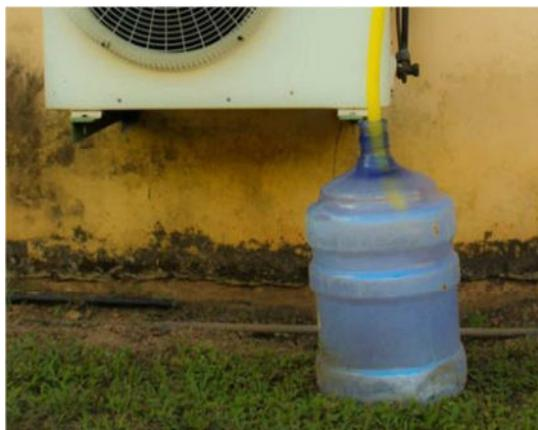
**Figura 3. Protótipo de coleta manual.**
