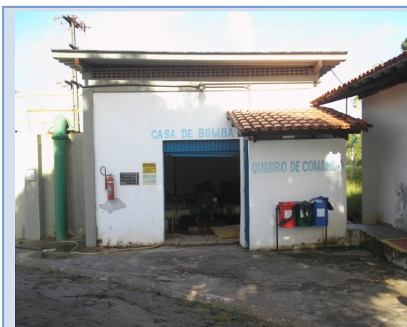
Figura 118 - Vista externa da casa de bombas. Camaçari, junho de 2011.
