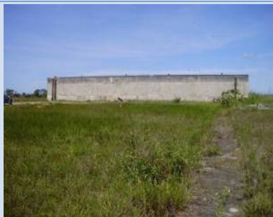
Figura 103 - Vista geral da área do RAD de 6.000m 3 . Camaçari, junho de 2011.
