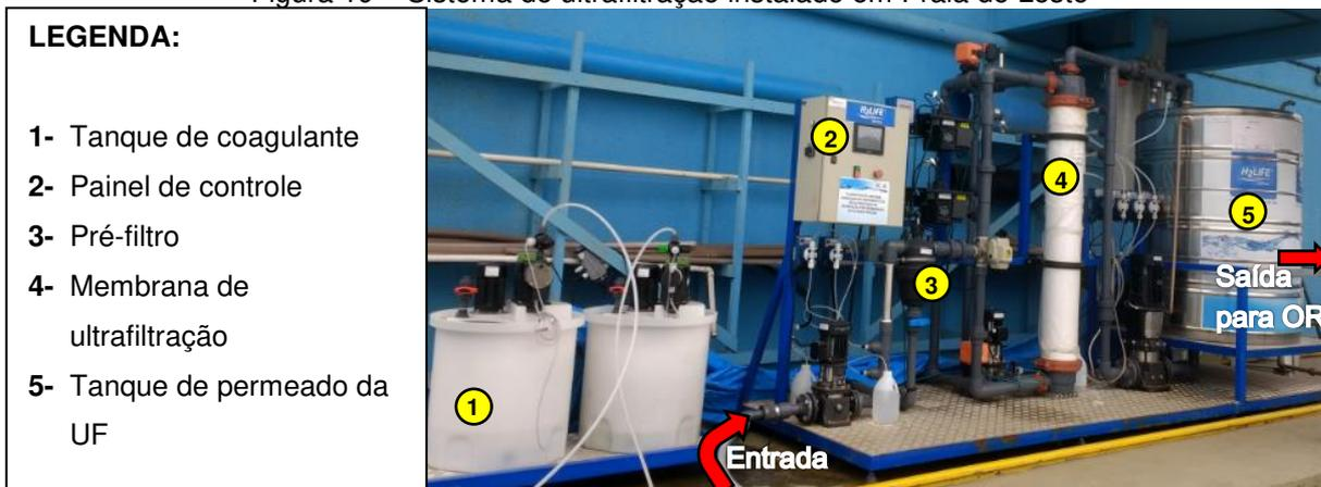
Seguindo o processo, a água passava por um pré-filtro (ponto 3 da Figura 19), para remover as partículas mais grosseiras e era bombeada para a membrana de ultrafiltração de escoamento vertical ascendente, identificado como ponto 4 da Figura 19.
