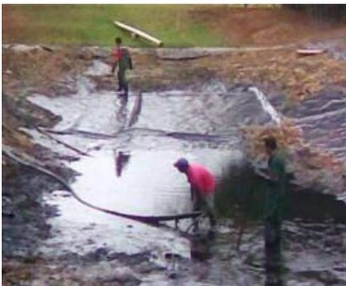
**Figura 9: Sucção de água e matéria orgânica.**
