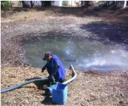
**Figura 13: Sucção de água e matéria orgânica.**
