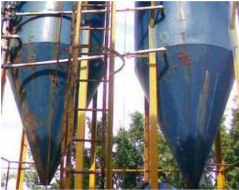
**Figura 05: Decantadores apresentando furos e oxidação.**
