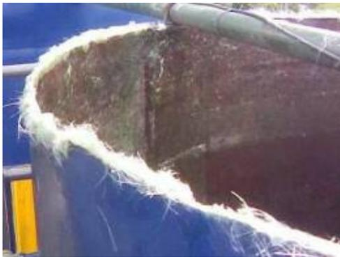
**Figura 07: Revestimento interno dos decantadores com fibra.**
