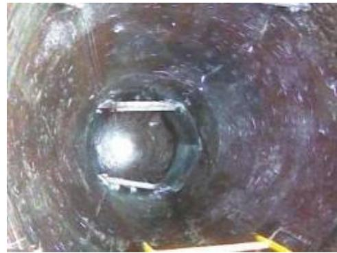
**Figura 08: Interior dos decantadores após revestimento especial.**
