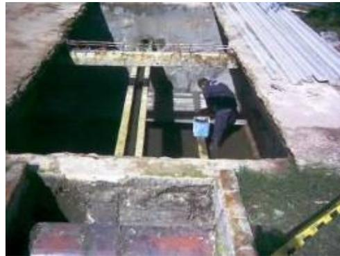
**Figura 02:** Remoção da estrutura do filtro.
