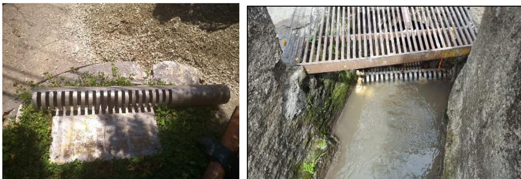
**Figura 3 – Peça Calha Coletora**
