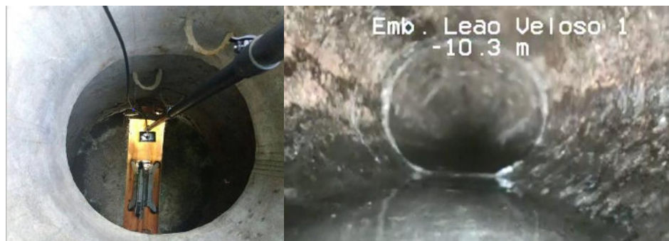
Imagens 3 e 4: Filmagem em rede e ramal de esgotos.
