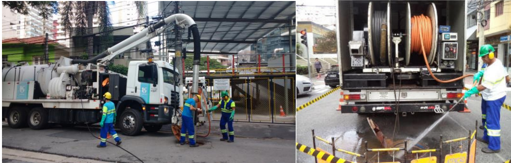
Imagens 1 e 2: Lavagem e Limpeza de rede de esgotos.
