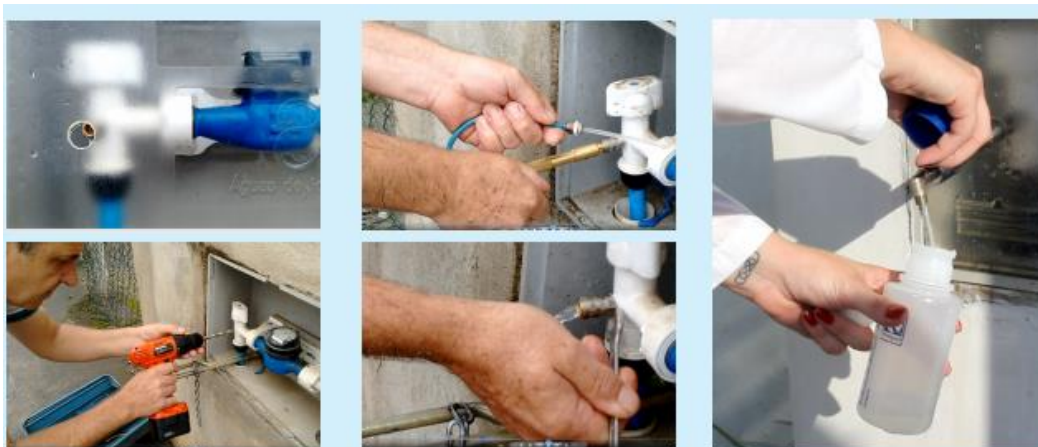
Figura 7: Instalação da ferramenta PCQO e demonstração de amostragem. Fonte: CAJ, 2015.
