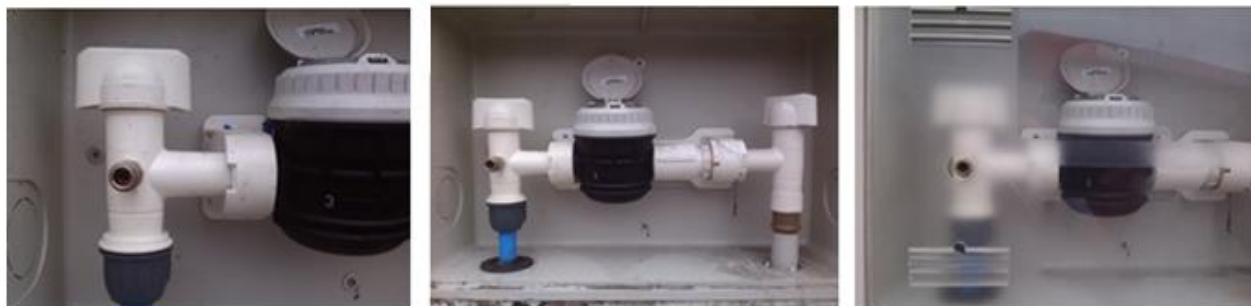
Figura 3: Primeiro sistema de engate rápido do PCQO.
