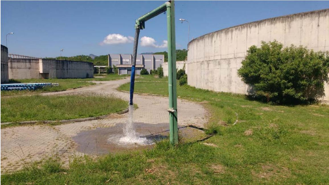
**Figura 1: Sistema de abastecimento dos caminhões pipa com água de reuso na ETE Alegria**
