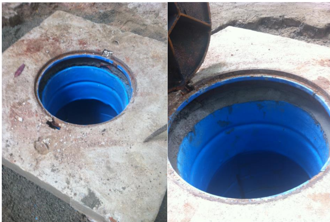
Figura 12: Laje instalada sem apoio sobre o PV.
