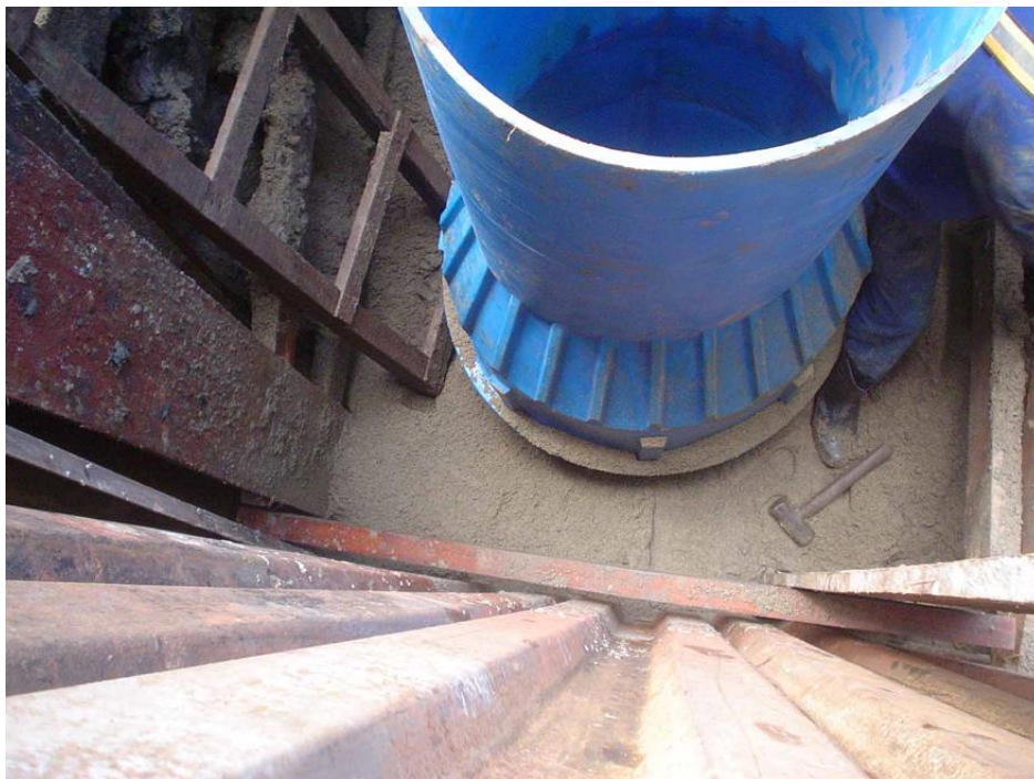
Figura 5: Escoramento e berço de arcia.
