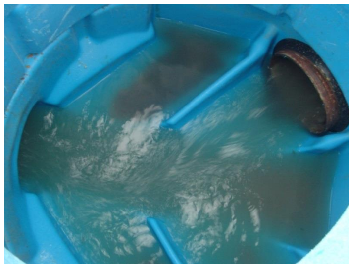
Figura 18: Vista interna de uma ligação em operação.
