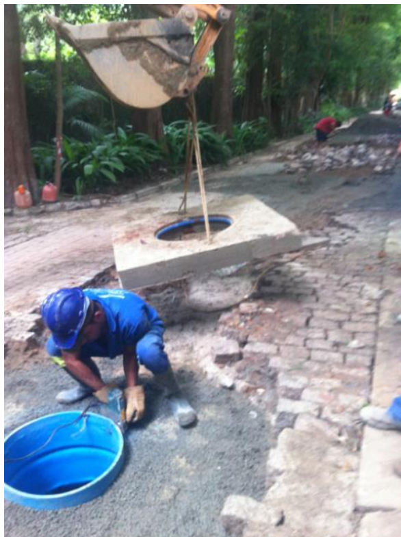
Figura 11: Montagem da laje pré-moldada.
