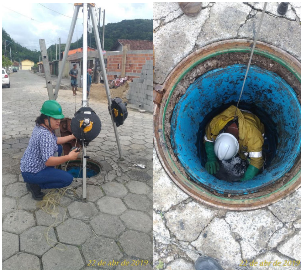
Figura 23: Teste de entrada em PV DN 800.
