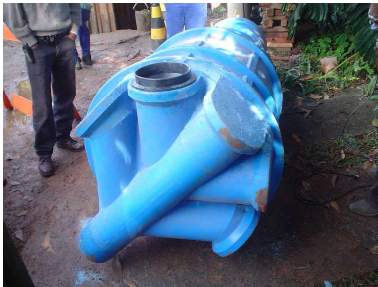
Figura 17: Junta flexível instalada.
