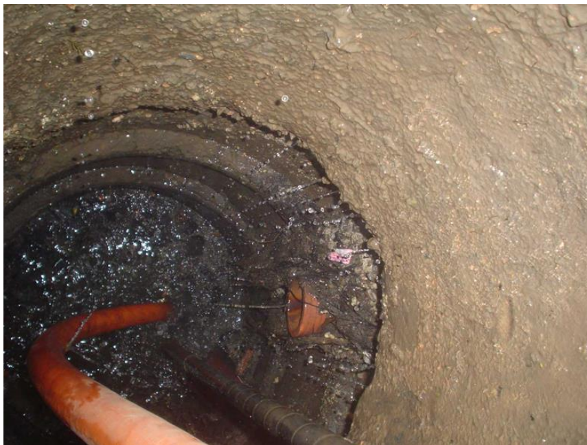
Figura 20: Infiltrações em PVs de concreto.
