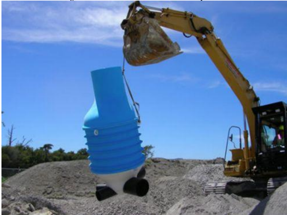
Figura 2: Manuseio com o auxílio de retroescavadeira.
