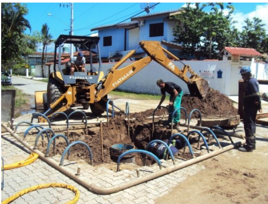
Figura 6: Rebaixamento de lençol freático
