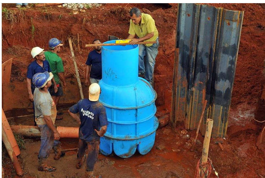
Figura 8: Nivelamento do PV em material plástico.
