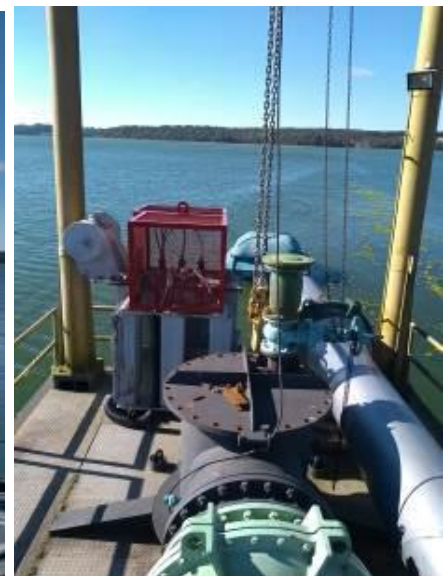
Figura 11, 12 e 13: Montagem da flange , transformador e tubulação recalque
