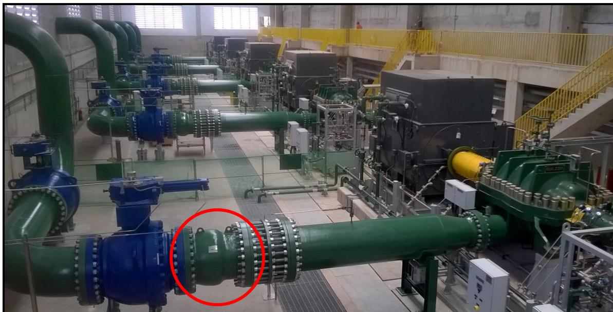
**Figura 3 – Foto da Vista Interna da EEAB- AC (Detalhe da válvula de retenção)**
