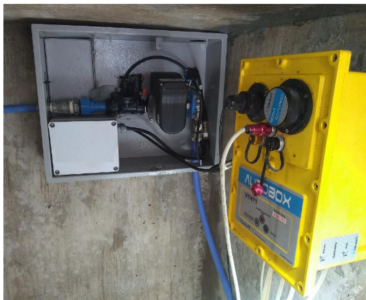
Figura 4: Instalação da microturbina na VRP Matão (Foto: Autor)
